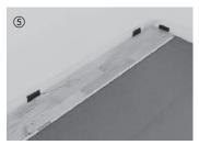
Начиная с правого угла комнаты, элементы укладываются гребнем к стене и фиксируются распорными клиньями или дистанционной прокладкой (расстояние до стены для компенсации расширения 10 - 15 мм).
