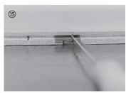
Совет по расцеплению Тор Connect: Элементы можно демонтировать путем расцепления. Для этого инструмент для расцепления вставляется со стороны торца шпунта.
