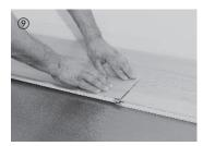
Затем элемент опускается с торца. При этом обратите внимание, чтобы элемент примыкал торцом заподлицо к ранее установленному элементу. Элемент входит при помощи короткого давления на поперечный стык.
