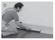
Оставшаяся часть первого ряда служит началом следующего ряда (смещение с торцовой стороны не менее 50 см). Благодаря этому существенно уменьшается количество отходов. Последующая укладка происходит поэлементно. Для этого элементы сначала вставляются продольной стороной с помощью легкого нажатия с поворотом в смежную доску.
