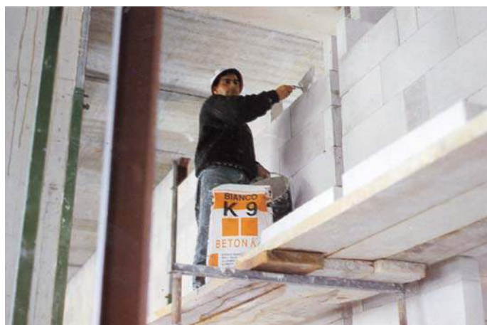
Кладка перегородок из пеноблоков
