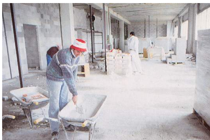
Приготовление раствора ВЕТОНКОЛ К9
